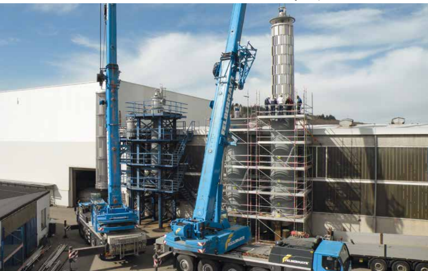
Einbau eines Kurzwegverdampfers © GIG Karasek
